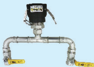
● 給水口配管部
